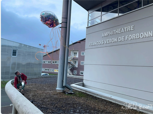
Installation des éclairages solaires par Pascal Garret - 19/11/2025
